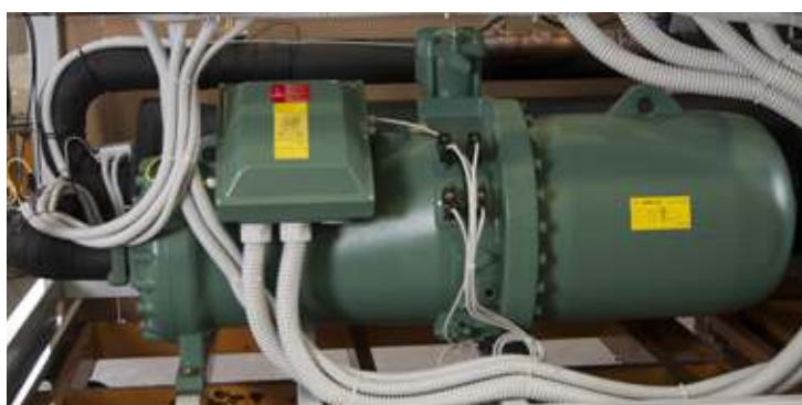
Compressore a vite - Screw compressor
